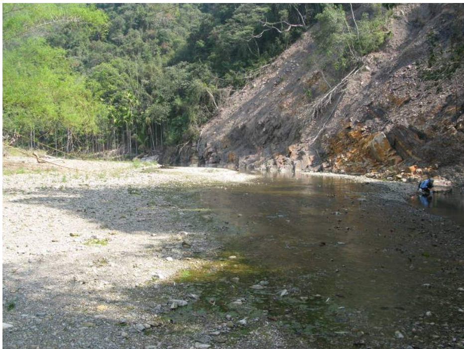
圖 3-1.2 石觀音樣站範圍有崩塌的狀況 (09/03/17)
