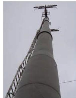
圖 6.2-3 單線自動循環式纜車系統線上支柱
