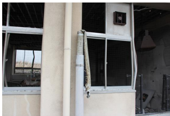
舊大野木場小學保存火山噴發被高溫 熔蝕的管線
