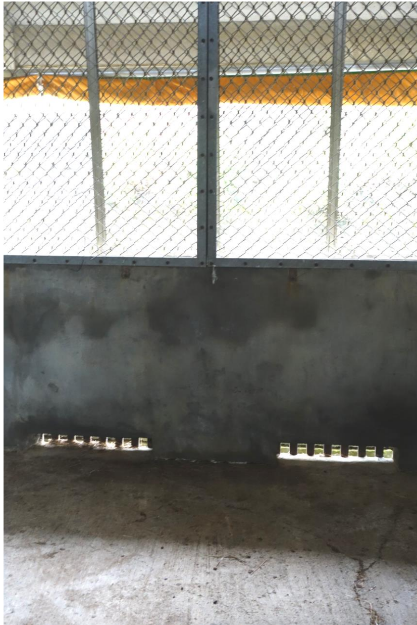
內部欄舍地板通風、排水開孔及紗窗不銹網設計
