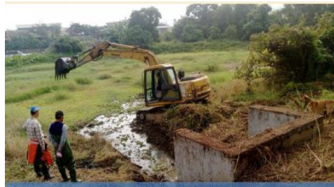
解決排水問題、現場整地施工狀況
