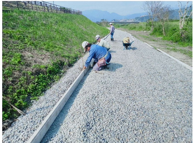
堤底步道施工
